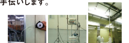
室圧差測定 清浄度測定 フィルターリーク試験
