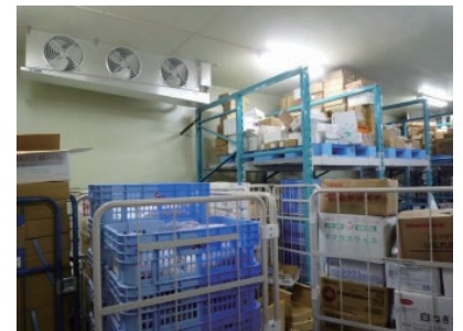
一時保管冷凍庫内の食品の温度管理をする庫内ユニット
