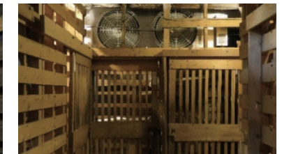
1階はコンデensingユニット+広フィンタイプのユニットクーラー
